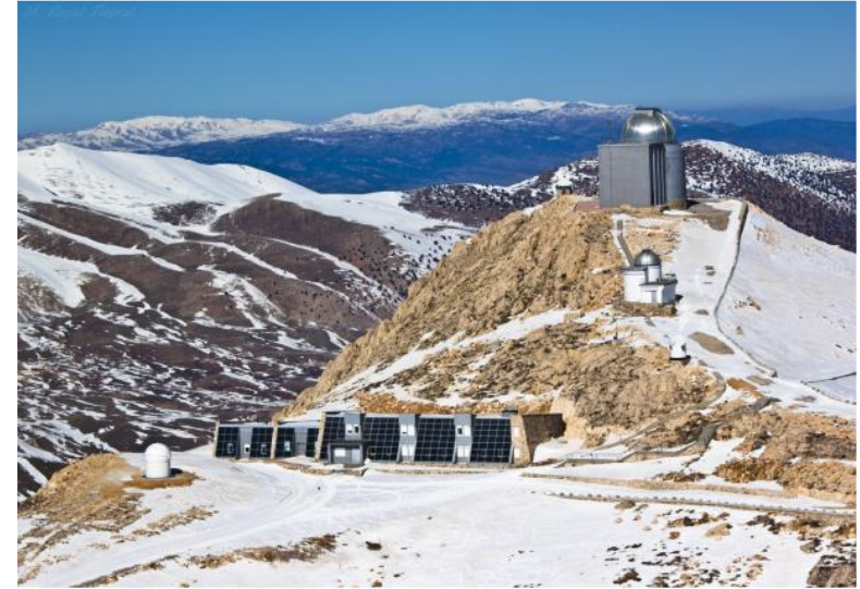
Bakırlitepe Site, Saklıkent
